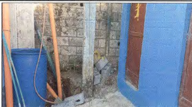
Foto 8: Sustitución de mingitorio
