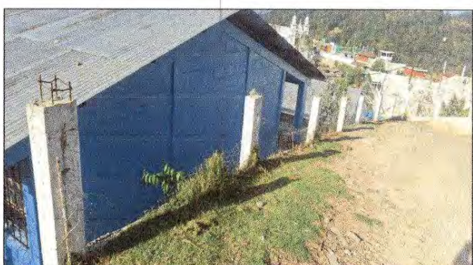
Foto 10: Reparación de muro perimetral de block con tubo hg y malla galvanizada, soleras intermedias y columnas.
