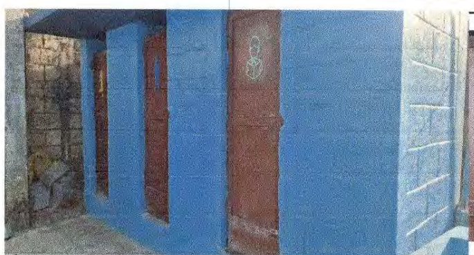
Foto 6: Mantenimiento a estructura (lijado, cambio de tubo , cepillado, sujeciones, aplicación de pintura) a puertas servicios sanitarios
