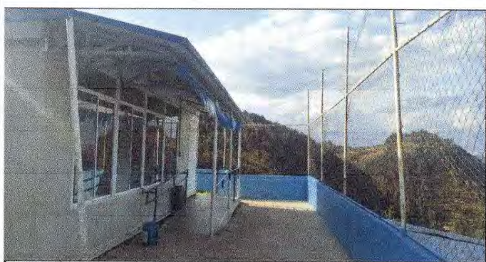
Foto 5: Sustrucción de canal de pvc
