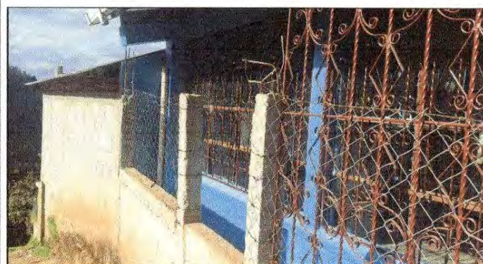
Foto 9: Sustitución de barandas de metal.
